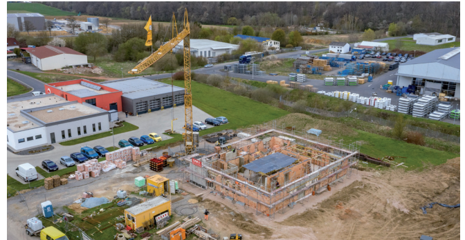
Der Neubau am 23. April 2021: Der Rohbau wächst.
