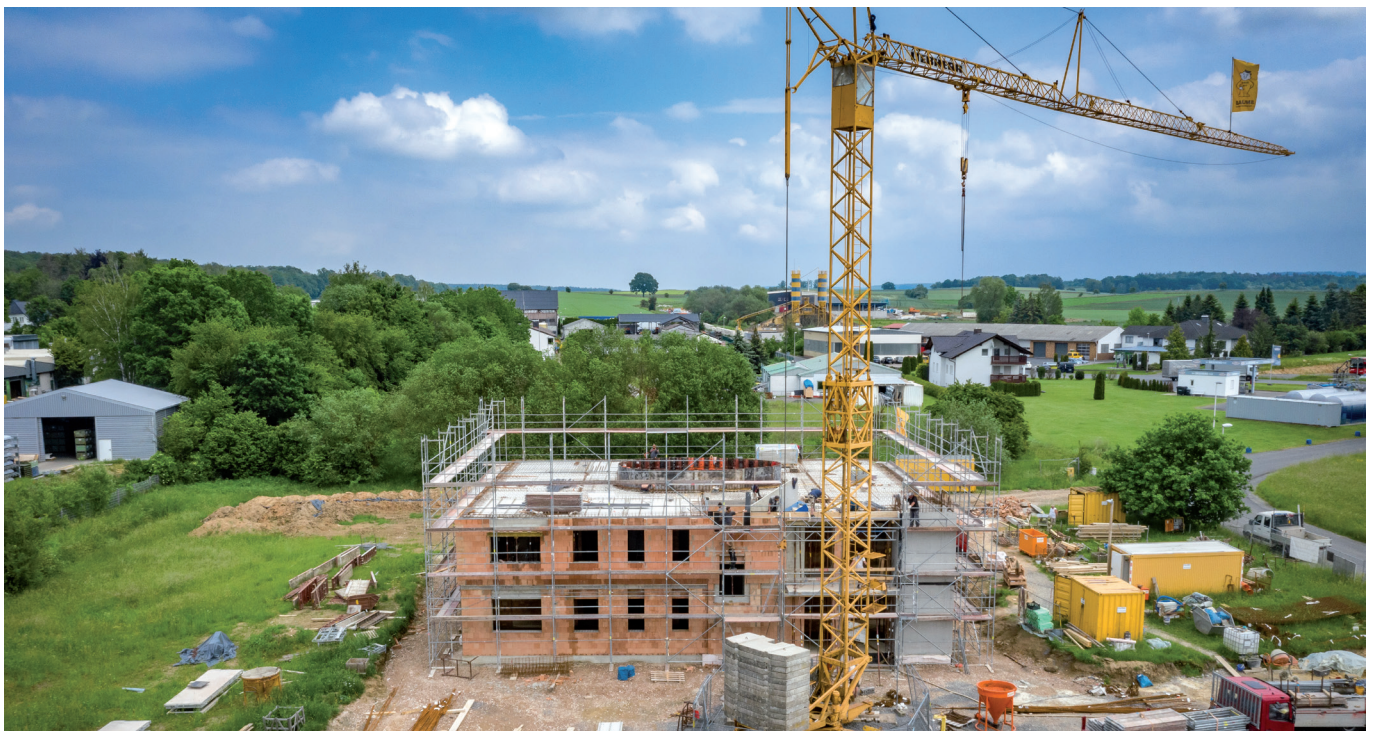
Am 8. Juni: Das 1. Obergeschoss ist fertiggestellt.
